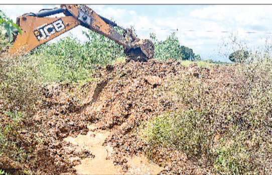
अंबाला। अवैध कॉलोनी में हुए निर्माण को दहती जैसी बी।
